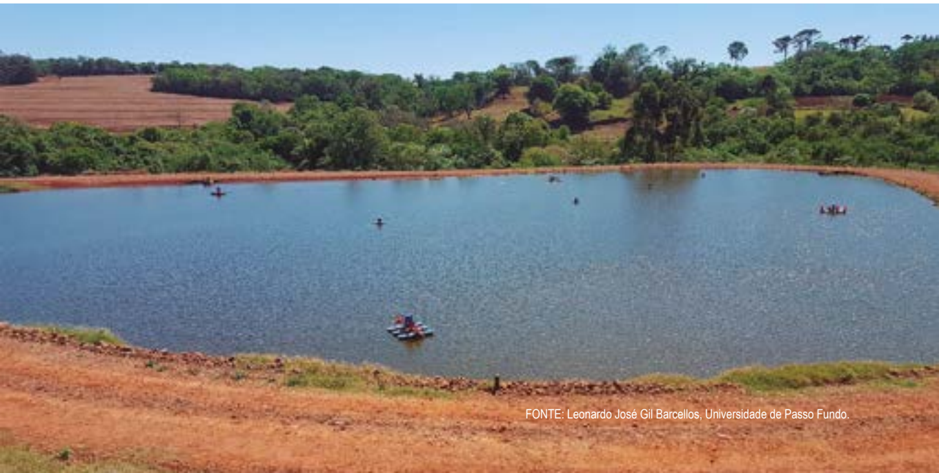
FIGURA 5.6 - Tanque escavado de formato irregular
