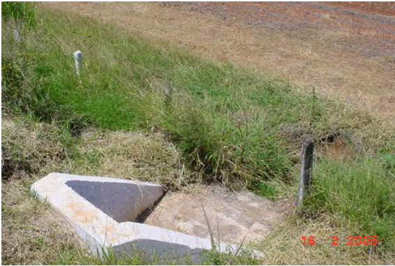
Figura 1. Saída de águas pluviais de uma rodovia, sem dissipador de energia e encaminhamento às áreas agrícolas. Rod. SP 127 km 127 – Norte.
