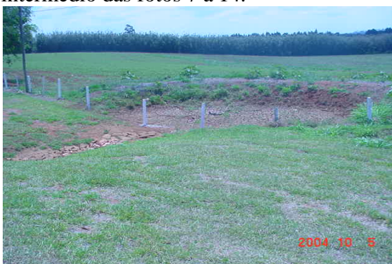
Figura 7: Observar a bacia de contenção construída na propriedade adjacente à estrada. SP 270 km 156 + 900m Leste.
