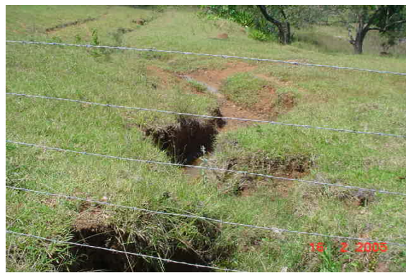
Figura 4: Sulco de erosão à jusante da saída anterior.
