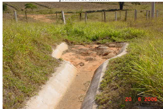
Figura 10: Pedras de concreto em outro dissipador de energia no mesmo local.
