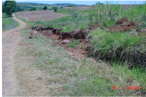
Figura 2. Voçoroca causada por águas pluviais da saída ao lado.
