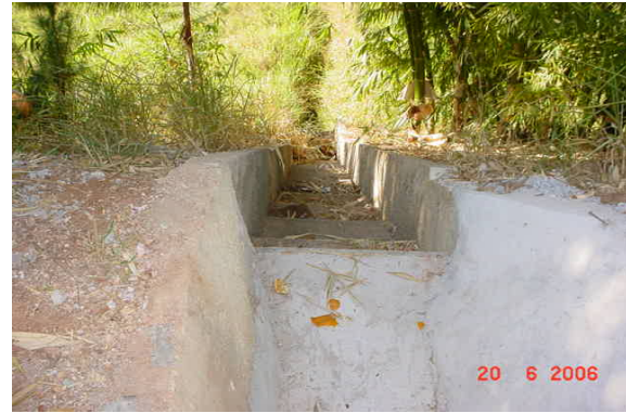
Figura 12: Escada Hidráulica na SP 127 km 127 + 200 m Norte
