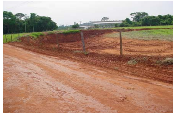
Figura 6. Estrada com "camalhão" e saída de águas pluviais para um "bigode" Data 23/11/05.
